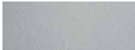
PLAFONNAGE (PLÂTRE, ENDUIT)
